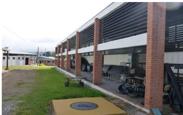
CONSTRUCCIÓN DE LOS LABORATORIOS DEL DECAT ELECTRICIDAD Y SOLDADURA ₡ 78.038.923,51 2008
