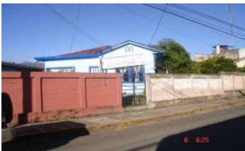
Fotografía N°7 Antiguas Instalaciones Patio de Soldadura
